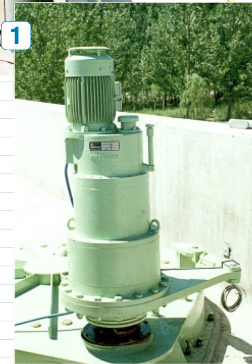
1 Reductor planetario HILLMANN de 3 etapas para accionamiento de viga barredora en batea de clarificación (Mendoza)
