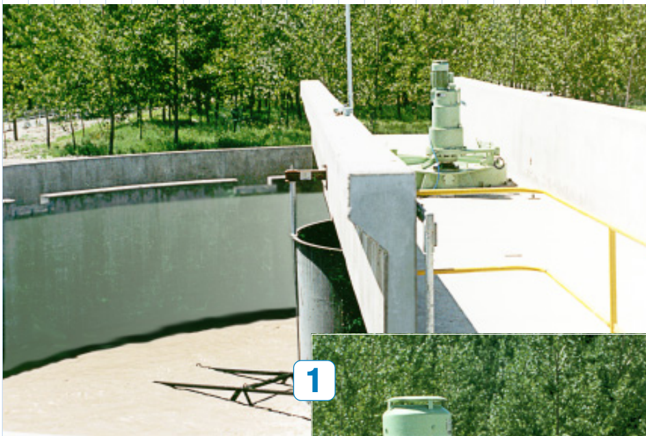
1 Reductor planetario HILLMANN de 3 etapas para accionamiento de viga barredora en batea de clarificación (Mendoza)
