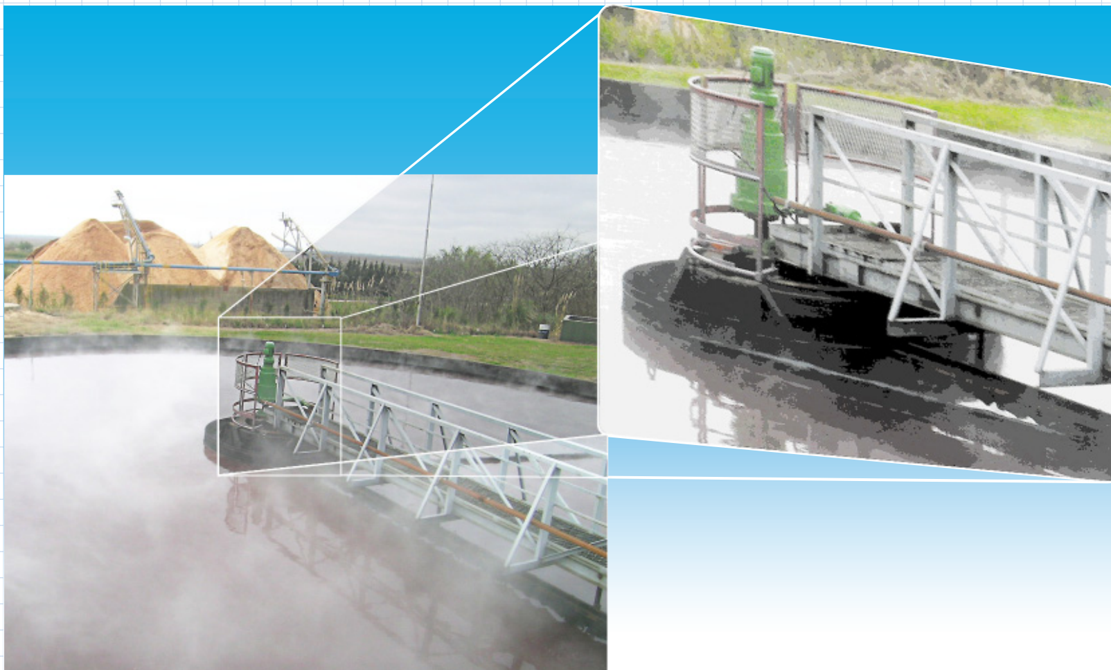
Motorreductor HILLMANN combinado coaxial-planetario para accionamiento de clarificador instalado en una planta de elaboración de papel. Se destaca la compacidad del equipo frente a otras soluciones de accionamiento basadas en doble sinfin y corona.
